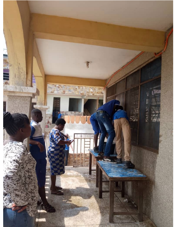
Pojat pesivät ikkunoita. Työnjohto tarkkana.
