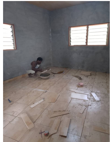
Lisärakennuksen yläkerran lattiatyöt edistyvät.
